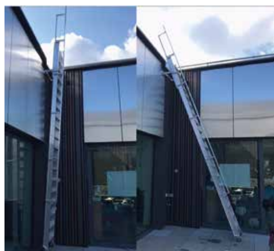
• Echelle d'accès toiture avec position de rangement
