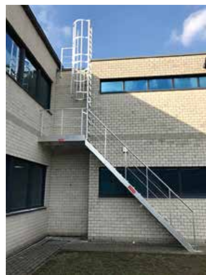
• Escalier + échelle à crinoline
