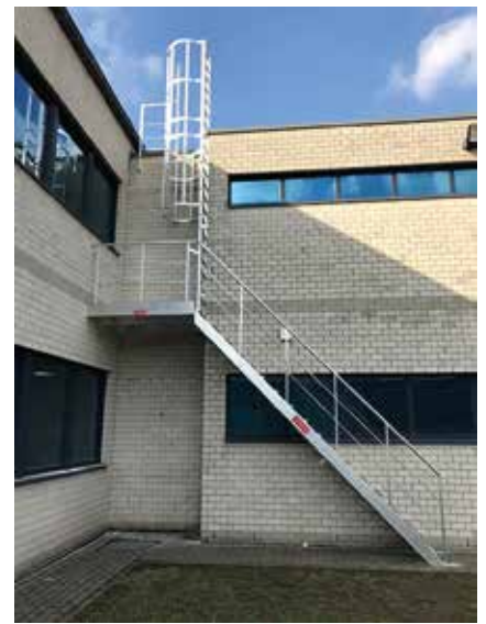
• Escalier + échelle à crinoline
